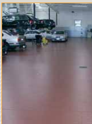
posadzka wykonana z płytek Argelith
