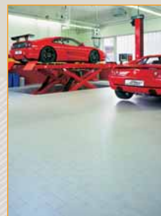
posadzka wykonana z płytek Argelith
