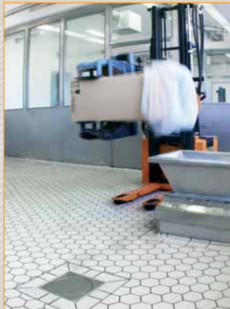
▲ przemysł farmaceutyczny posadzka wykonana z płytek Argelith
