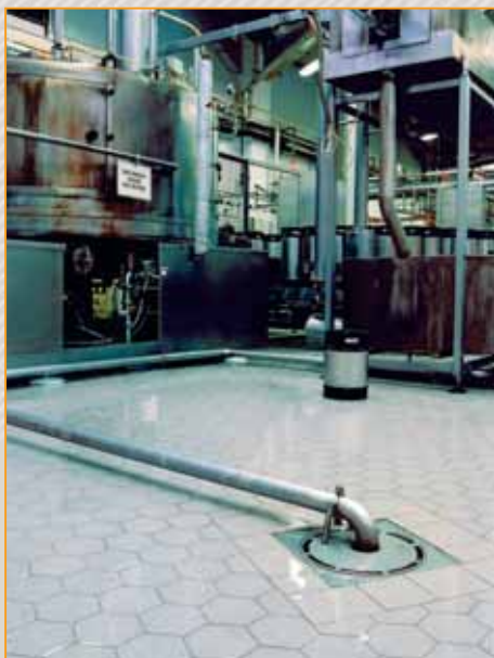
▲ zakłady chemiczne posadzka wykonana z płytek Argelith
