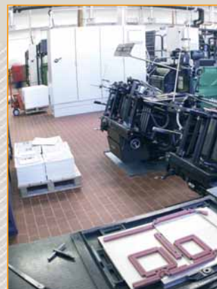
posadzka wykonana z płytek Argelith
