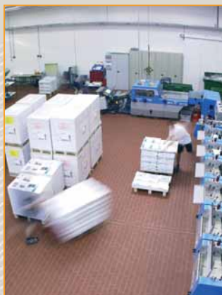
posadzka wykonana z płytek Argelith
